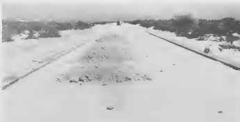
PILES of fill lie awaiting the grader on MOYTONVAN di terra ta wardando e grader cu unpaved section north of der ariba e seccion di pa nord di Pova Beach.
